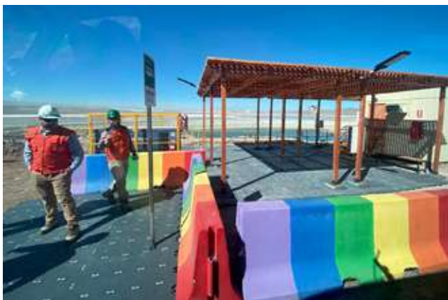
Piso reciclado instalado en el mirador de Spence
