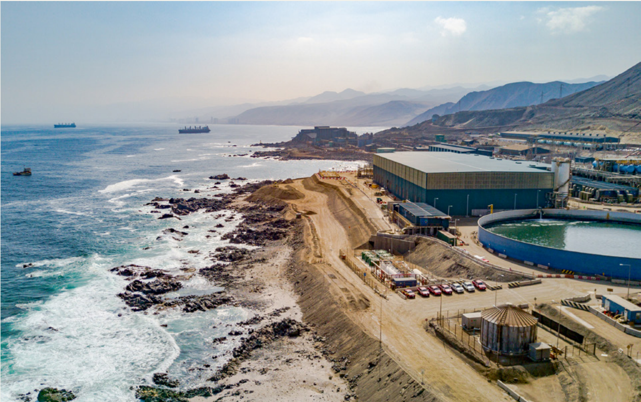
Planta desaladora ubicada en Puerto Coloso.
