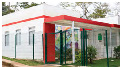
Escola Municipal Gustavo Capanema, reconstruída na praça de Gesteira.
