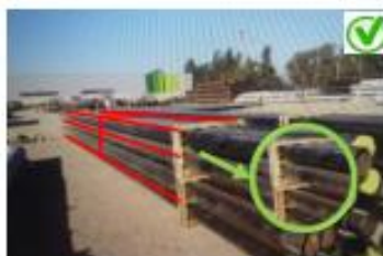
Entrega de tubos: Instalar travesaños entre los pisos, mejora considerablemente la estabilidad como la agrupación total de tubos al
