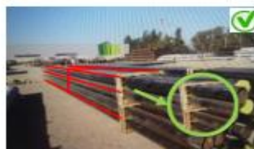
Entrega de tubos: Instalar travesaños entre los pisos, mejora considerablemente la estabilidad como la agrupación total de tubos al
